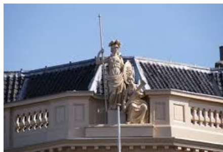
Dakbalustrade van het Hodshon huis
